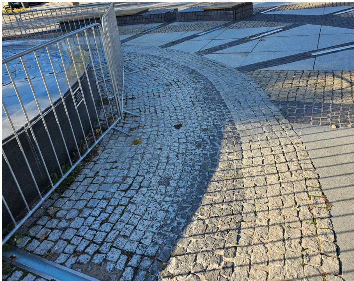
Zdjęcie 3 Kostka granitowa do wymiany. Zauważalne przetarcia, utrata koloru i estetyki. Źródło: Własne (2024).
