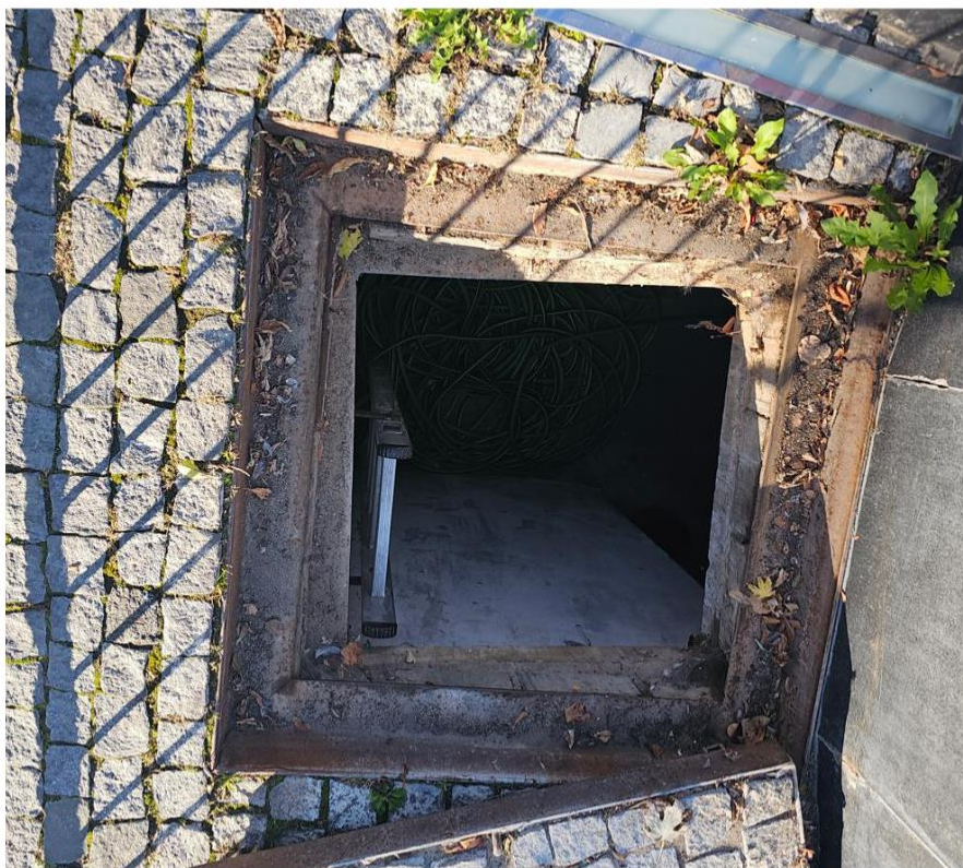
Zdjęcie 15 Istniejący właz do pomieszczenia technicznego. Źródło: Własne (2024).
