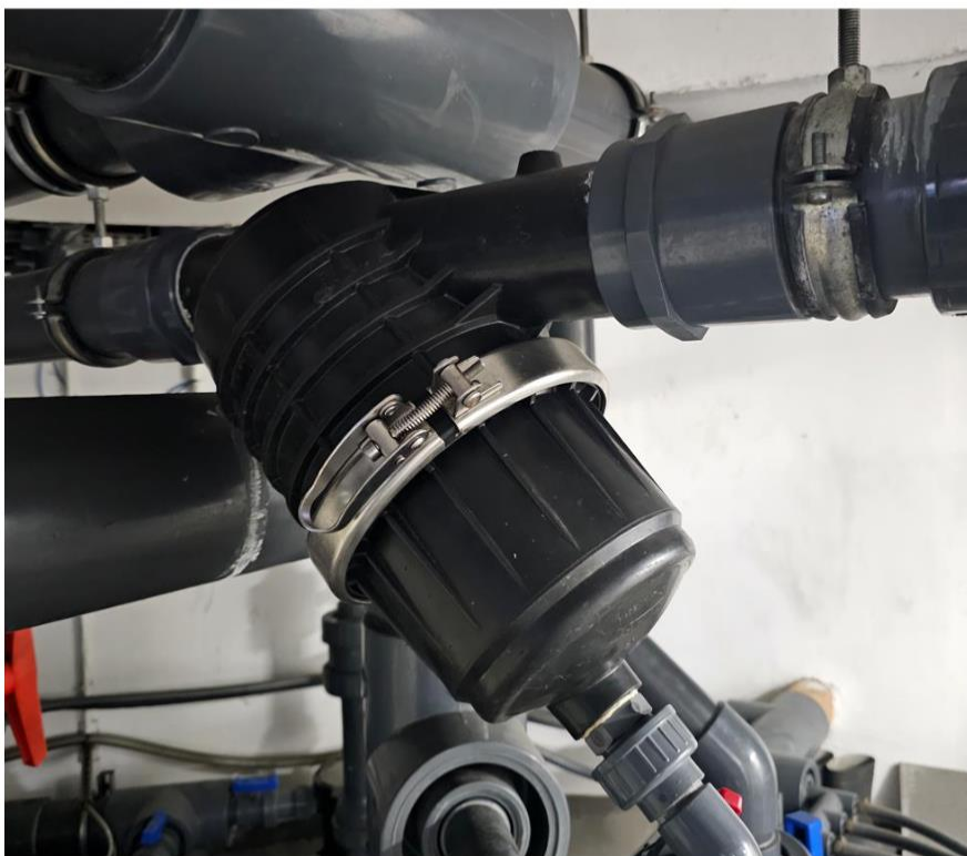
Zdjęcie 12 Filtr ARAG na instalacji tłocznej. Źródło: Własne (2024).
