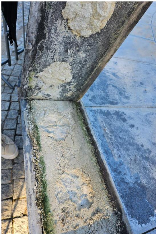
Zdjęcie 2 Ubytki oraz pęknięcia okładziny kamiennej. Źródło: Własne (2024)
