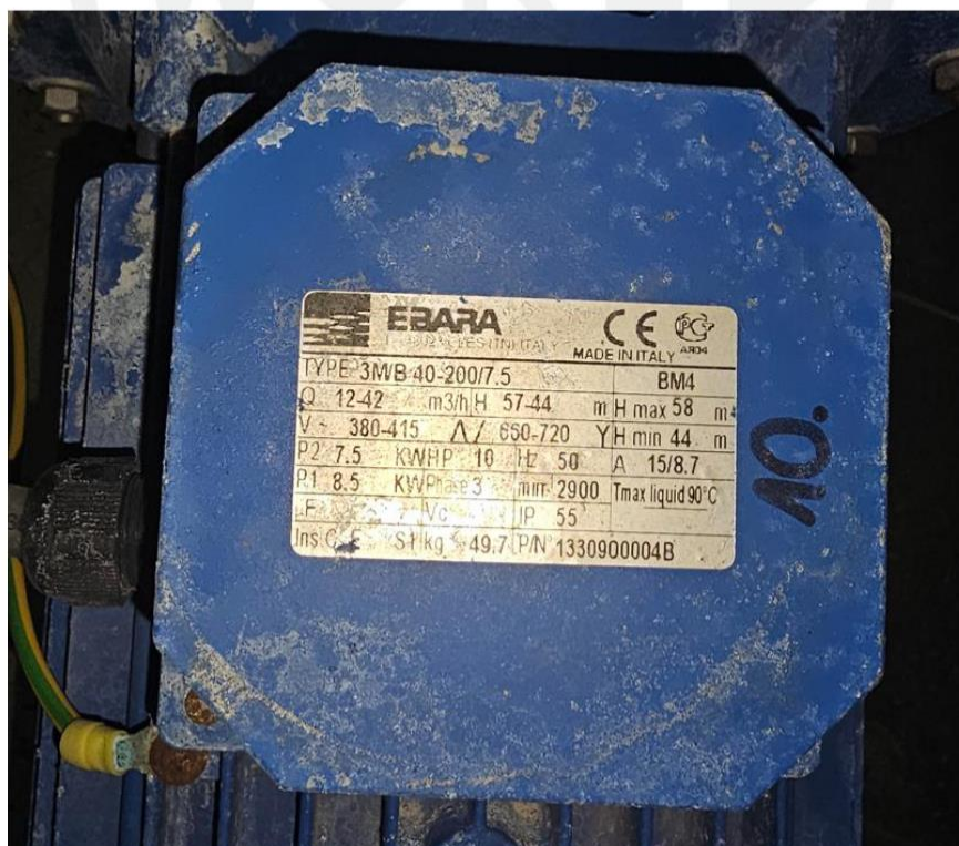
Zdjęcie 13 Tabliczka znamionowa pompy EBARA do wymiany. Źródło: Własne (2024)
