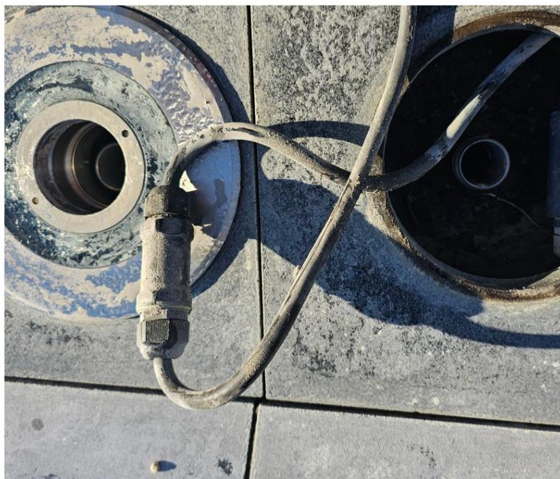
Zdjęcie 7 Istniejące złączki IP68. Źródło: Własne (2024).
