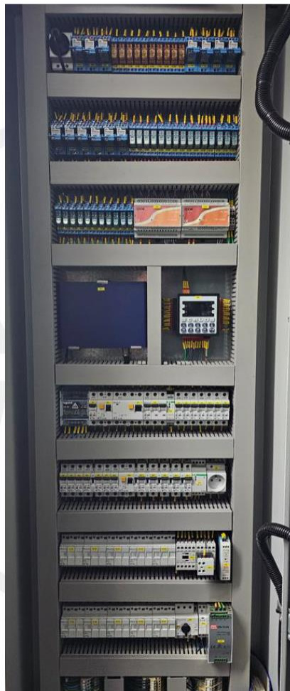
Zdjęcie 16 Istniejąca Szafa zasilająca - sterująca fontanny. Źródło: Własne (2024)
