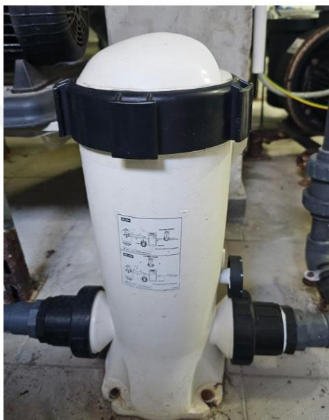
Zdjęcie 14 Istniejący chlorator przepływowy. Źródło: Własne (2024)
