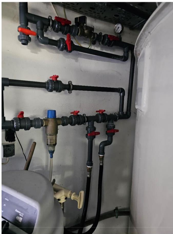
Zdjęcie 9 Instalacja wody surowej - dopuszczanie wody świeżej. Źródło: Własne (2024).
