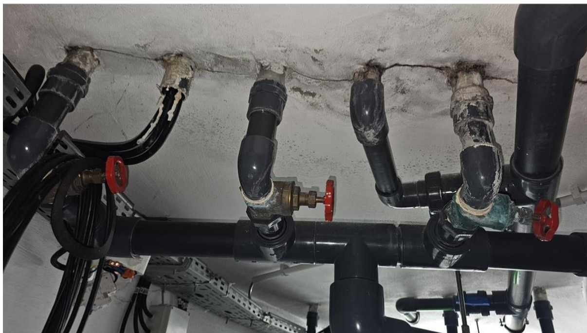
Zdjęcie 5 Istniejące zawory grzybkowe regulacyjne dysz spieniających - 36 sztuk. Źródło: Własne (2024)
