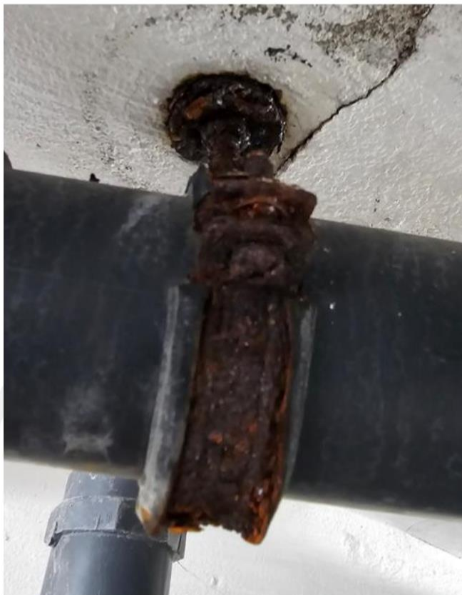
Zdjęcie 11 Skorodowane elementy montażowe. Źródło: Własne (2024).
